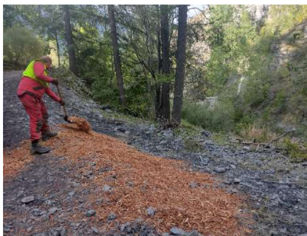
Prove di impiego di cortecchia per pacciamatura scarpate recuperate e consolidate con tecniche di ingegneria naturalistica
