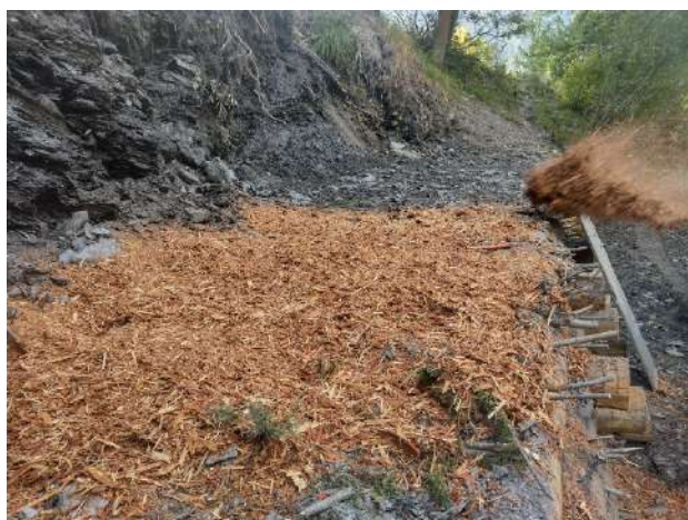
Prove di impiego di cortecchia per pacciamatura scarpate recuperate e consolidate con tecniche di ingegneria naturalistica
